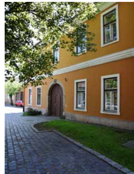
Lakóház, egykori Arany Csillag szálloda, vendégfogadó, Kossuth tér 3.
